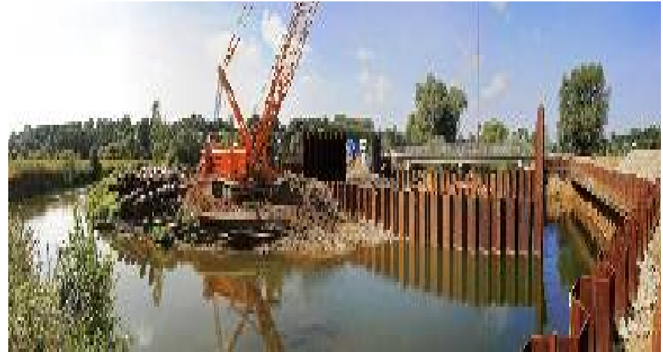
Site de Proisy (Aisne) : projet de ralentissement des crues de l'Oise – Source : entente Oise-Aisne
